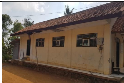
Tampak samping bangunan
