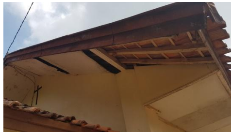
Kondisi Atap Bangunan
